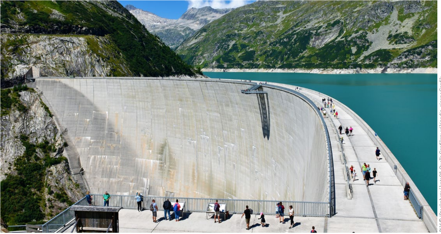
Die Kölnbreinsperre im Maltatal in Kärnten – Teil des leistungsfähigsten Pumpspeicherkraftwerks Österreichs
