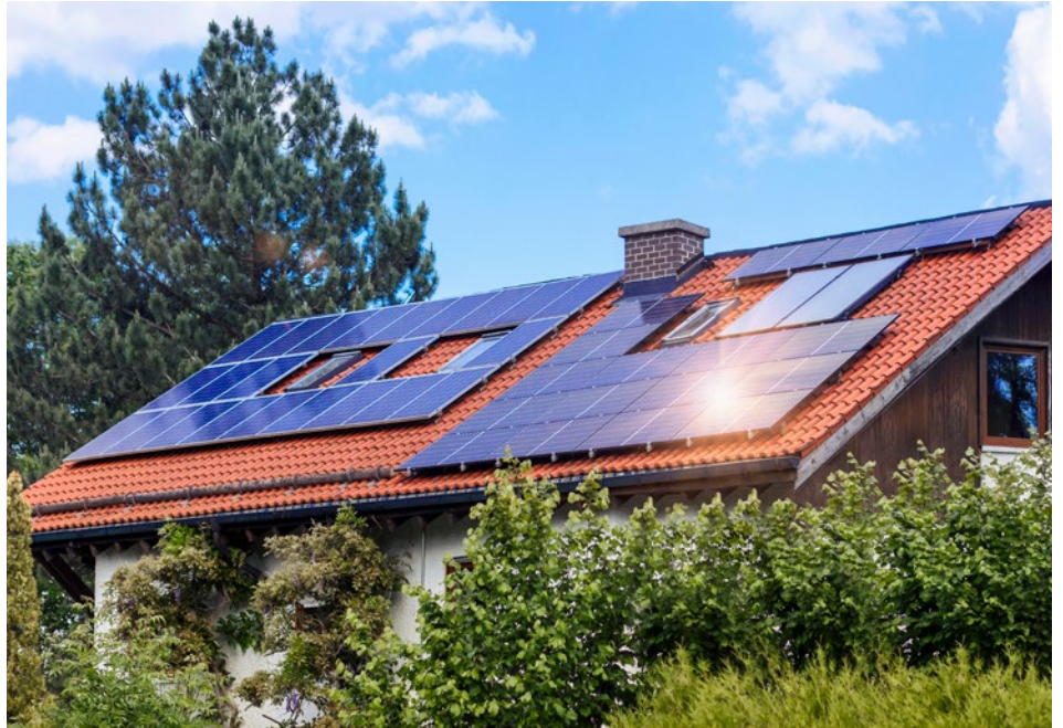
Photovoltaik allein ist schon ein großer Schritt in die richtige Richtung – wirklich sinnvoll wird sie gemeinsam mit einem Stromspeicher
