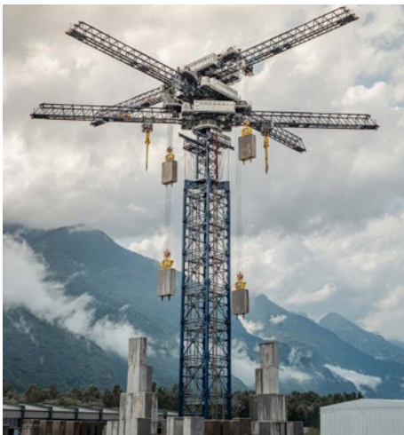
Test-Turm eines Schwerekraftspeichers / Hubspeicherkraftwerks der Schweizer Firma Energy Vault ...
